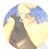
Монтаж (отстраняване на вода)
