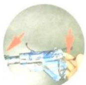
Ispravite kabel (instalacija)
